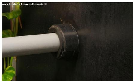
mit Silicon eingeklebt, nehmen die Röhren sicher auf und verdrehen sich nicht unter Last. Sie sind dreiteilig aus 80mm PVC gefräst. Ein Teil der Halterung nimmt eine Seite auf. Die beiden anderen Teile werden miteinander montiert und können um 180 Grad gegeneinander verdreht werden. Sie ermöglichen problemlos das Ein- und Ausbauen
